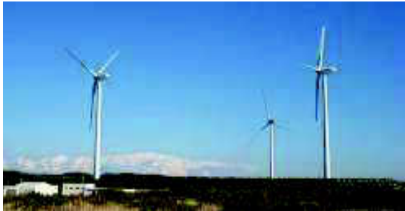
【御前崎風力発電所】
